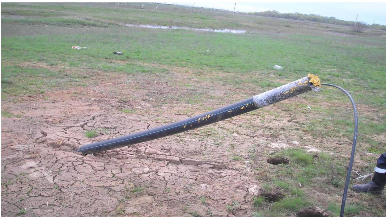
Рисунок Д.5 - Фото ВОЛС, выступающей над землёй на высоту более 1 м
