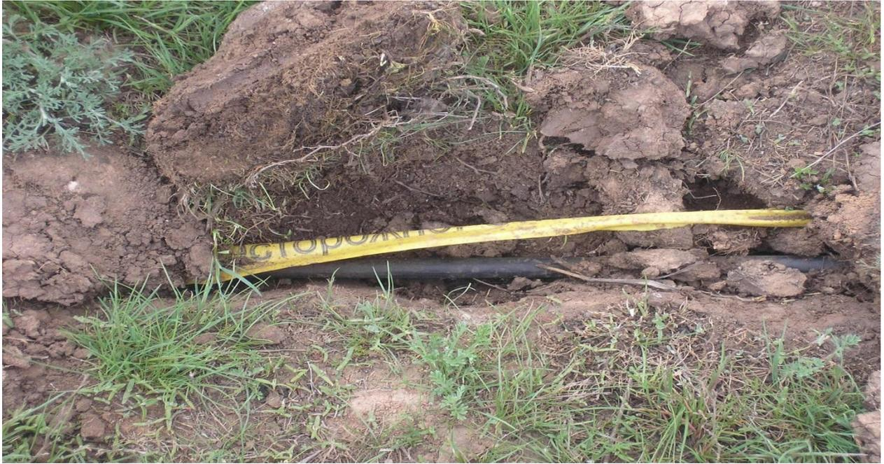
Рисунок Д.3 – Фото выступающего из-под земли оптического кабеля АСУ ТП: глубина прокладки кабеля менее 10 см (требуемая глубина 1.2 м)
